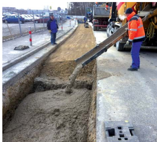
Verfüllung eines Rohrgrabens mit ZFSV
