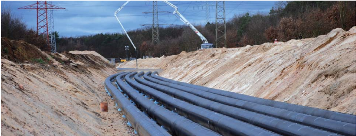
Versuchsanlage Kelsterbach – Rückverfüllung mit Flüssigboden (Quelle: Siemens AG)
